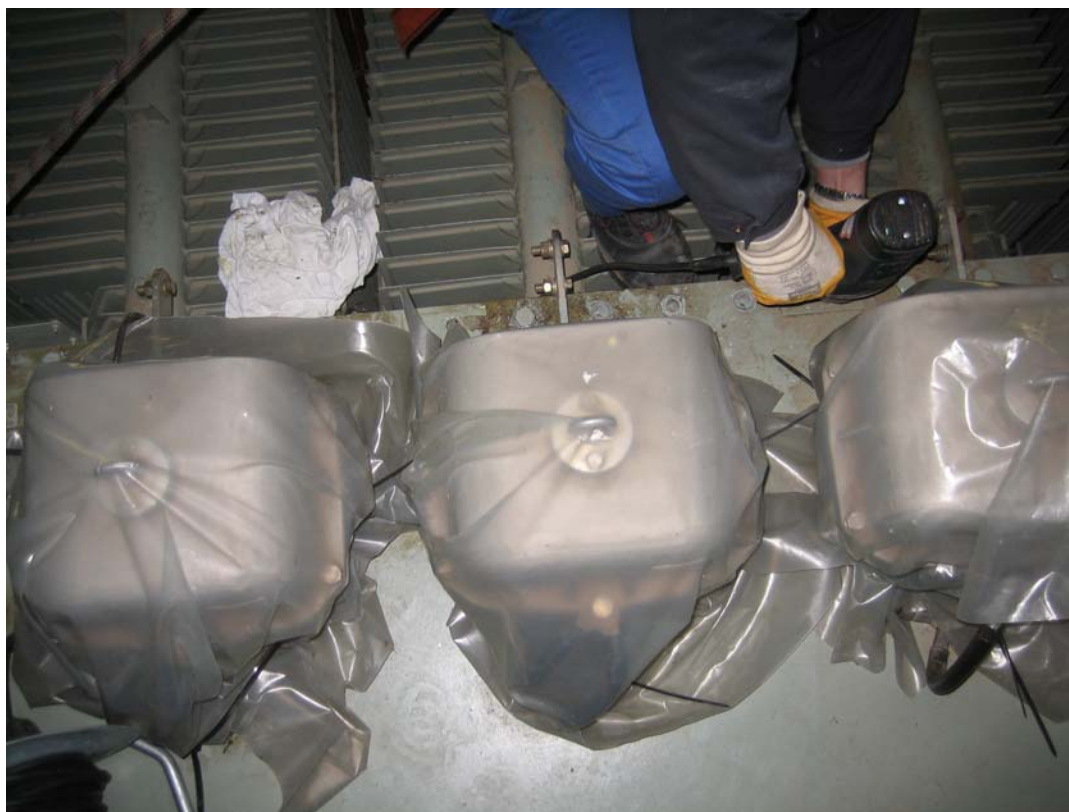
Zdjęcie 8 Odkręcenie śrub wieka
