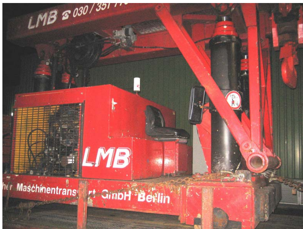
Zdjęcie 10 Przyjazd specjalnego podnośnika „BOOM- TRUCK“
