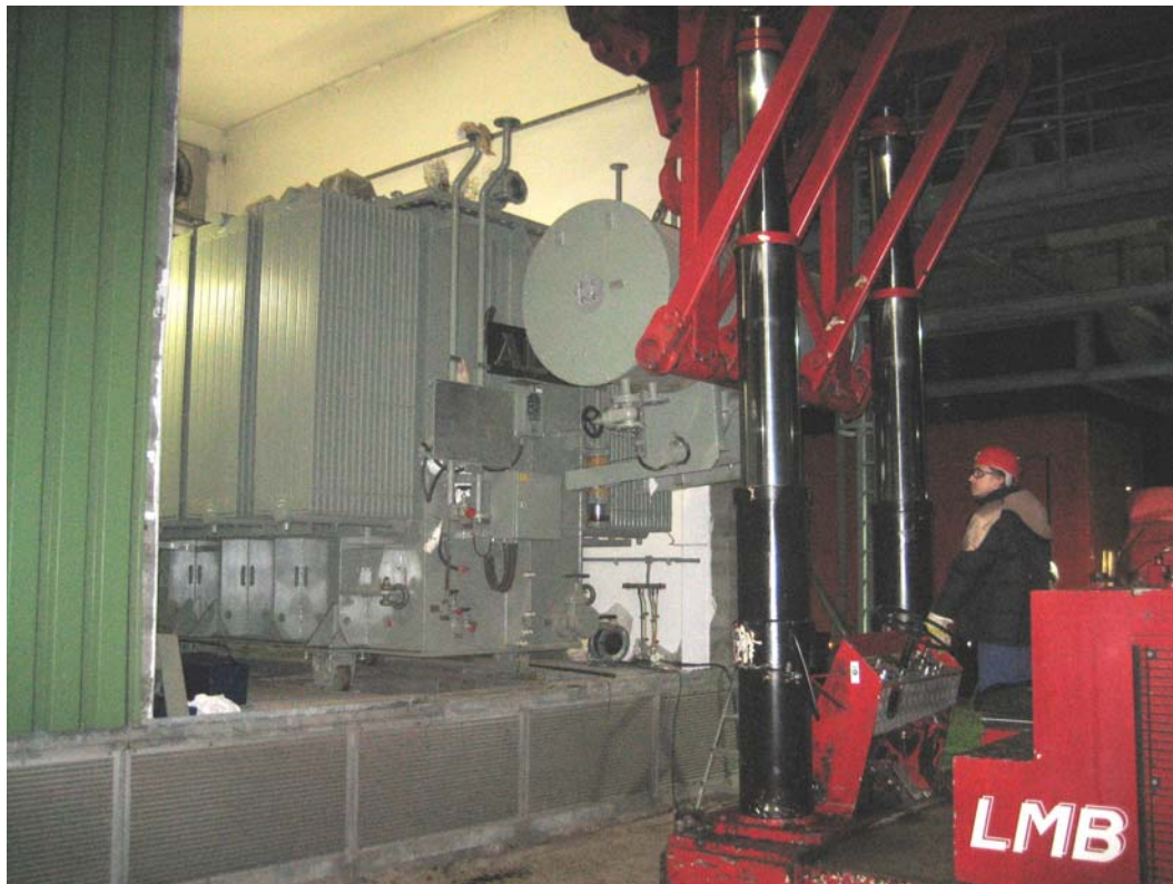
Zdjęcie 13 Demontaż konserwatora
