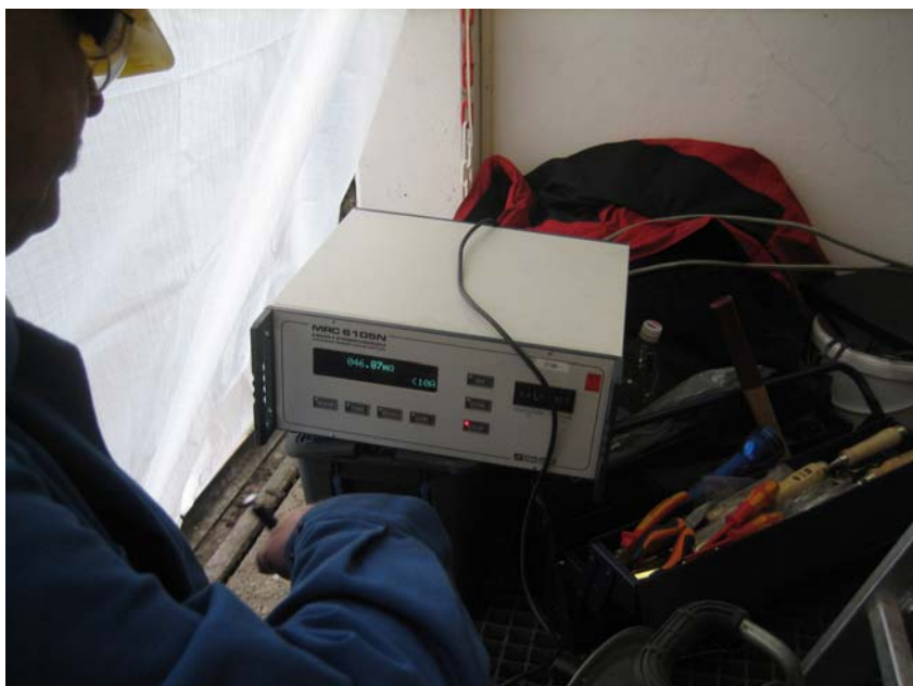
Zdjęcie 34 Pomiar oporności stykowej
