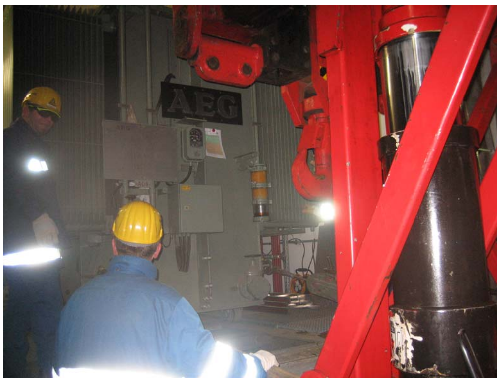
Zdjęcie 12 Przesunięcie transformatora
