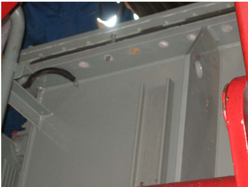
Zdjęcie 15 Podnoszenie wieka transformatora
