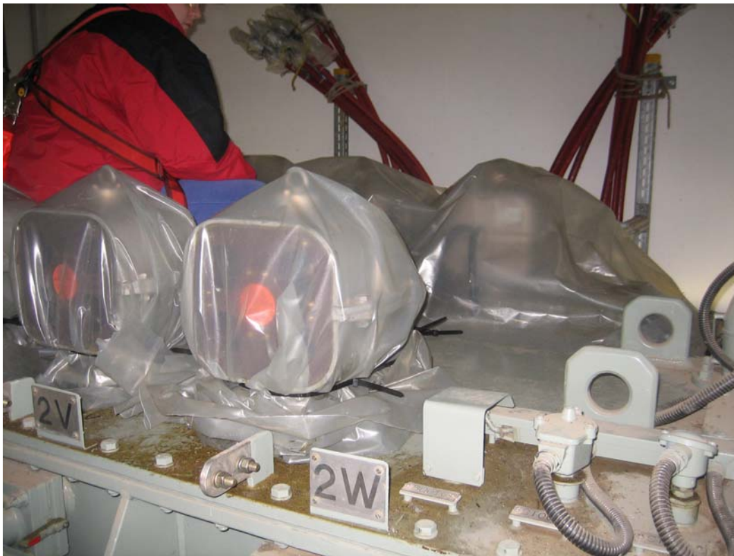
Zdjęcie 6 Zabezpieczenie przepustów
