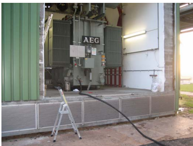
Zdjęcie 2/3 Odpompowanie 3.000 l oleju transformatora
