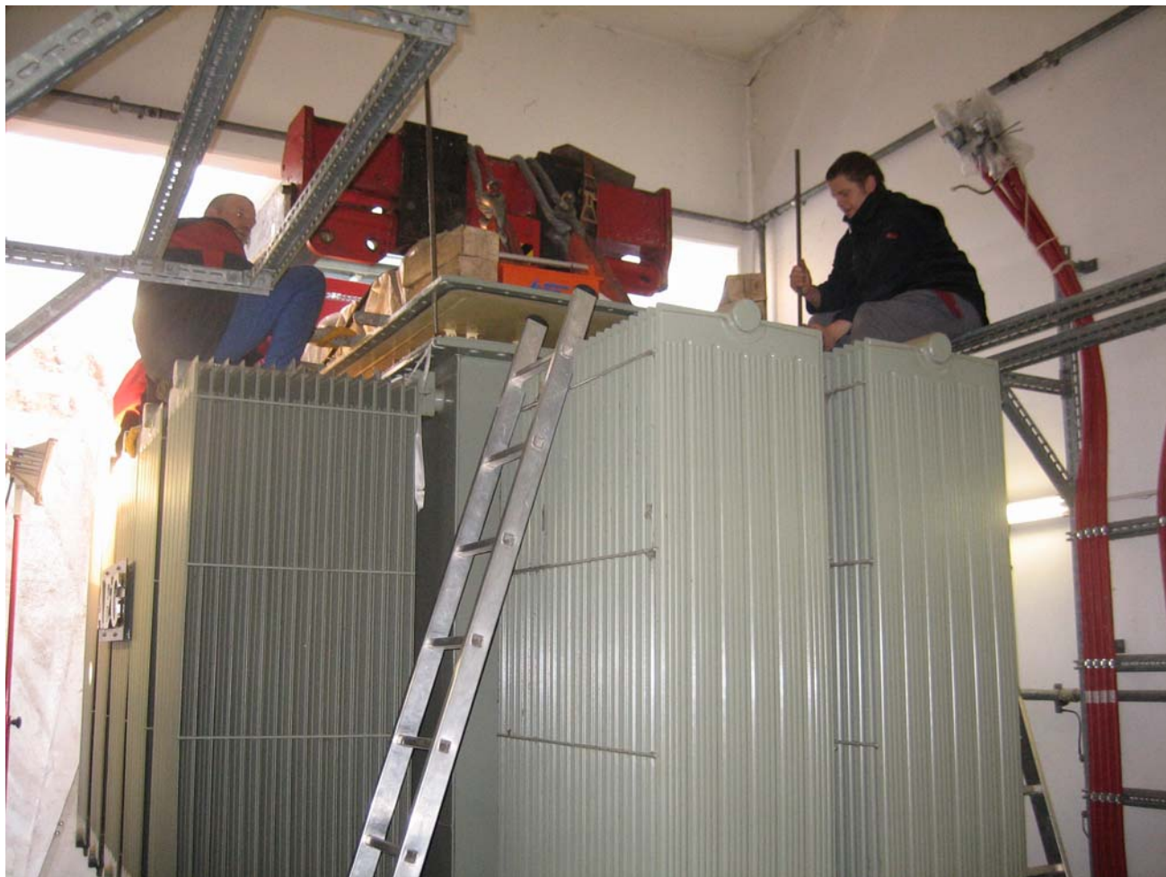
Zdjęcie 29 Dopasowywanie i opuszczanie wieka transformatora
