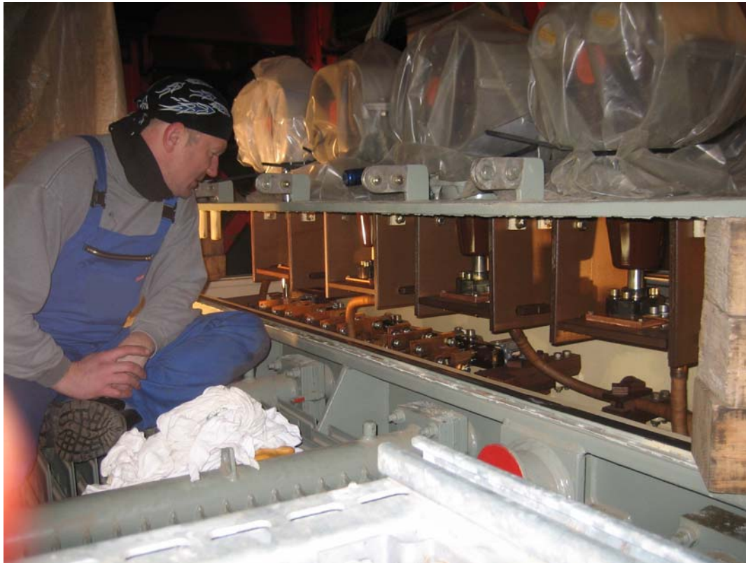
Zdjęcie 18 Zabezpieczone wieko transformatora, ogłędziny przełącznika
