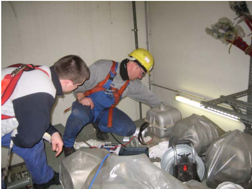
Zdjęcie 33 Pomiar izolacji
