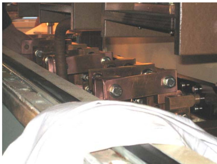
Zdjęcie 27 Nowe połączenia zastąpione przez szyny miedziane
