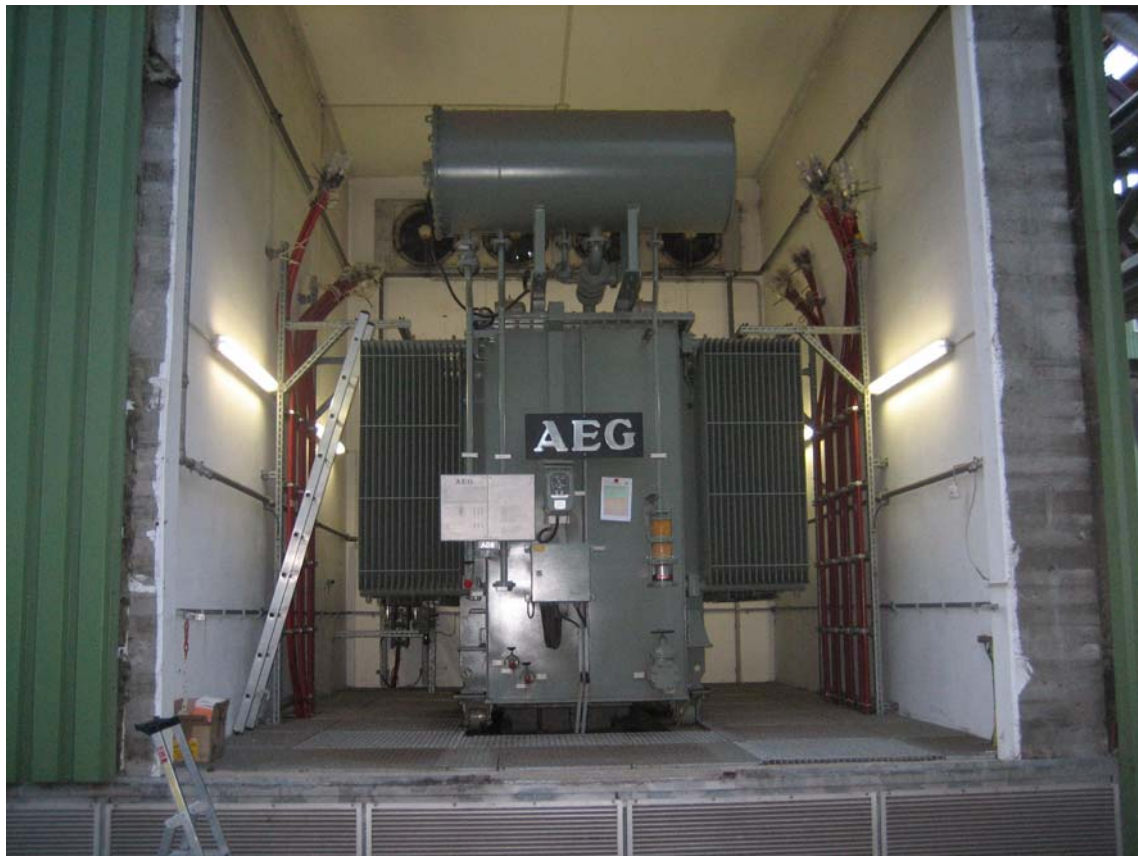
Zdjęcie 1 transformator przygotowany do prac remontowych
