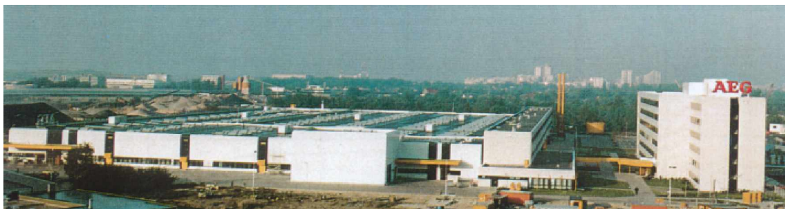
AEG Berlin Fabrik für Stromrichter und Antriebssysteme
